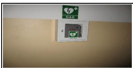
CORRIDOIO PIANO SEMINTERRATO
